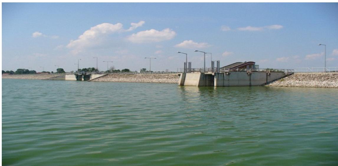
Fot. 1. Zapora czołowa zbiornika głównego
