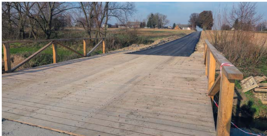
✦ Wyremontowany most oraz budowa nawierzchni asfaltowej w miejscowości Gruszka Mała Druga
