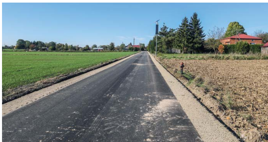
✦ Wybudowana w tym roku droga gminna w miejscowości Nielisz
