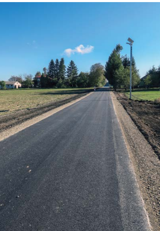
✦ Oddana do użytku droga gminna w miejscowości Nawóz
